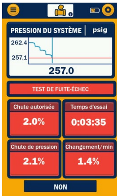
Figure 24: Test de décroissance de la pression - ÉCHEC
